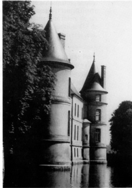
Fig. 7 - Château d'Haroué, construit par G. BOFFRAND, vue actuelle de la façade du côté du parc Cliché : D. Rabreau
