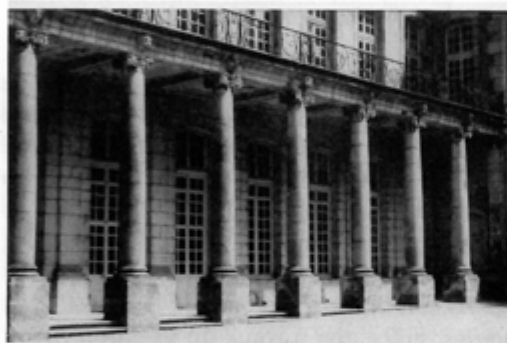
Fig. 8 - Château d'Haroué, construit par G. BOFFRAND, Vue actuelle du portique de la cour d'honneur Cliché : D. Rabreau
