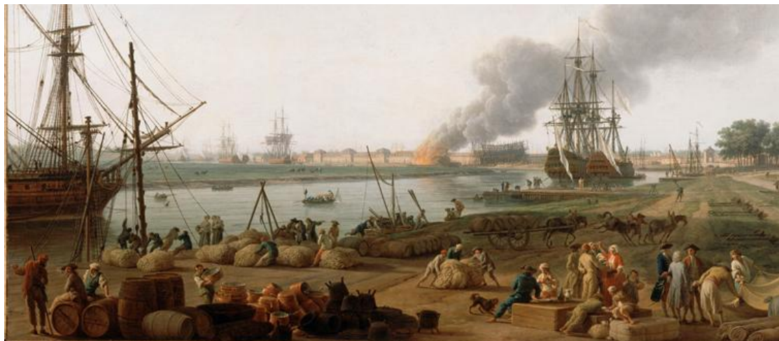
C.-J. Vernet, Vue du Port de Rochefort (détail), 1763
