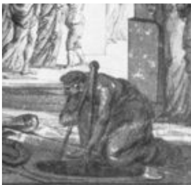
5 – Détail de la fig. 1 (à droite).
