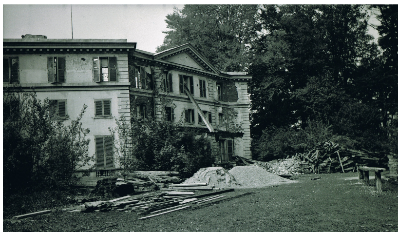
Fig. 14. 1984 le château de Colmoulins en ruine (cliché R. Bonmartel)
