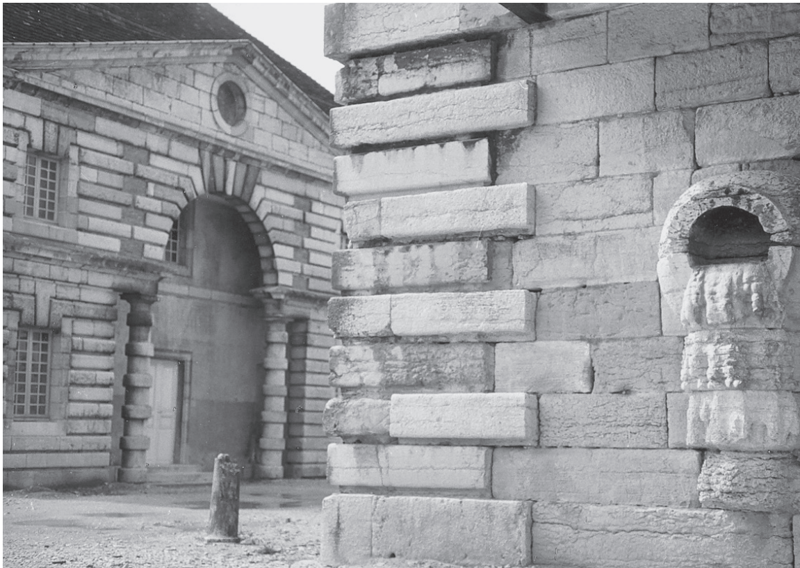
Vue des bâtiments des Commis et des Bernes de la Saline royale.
