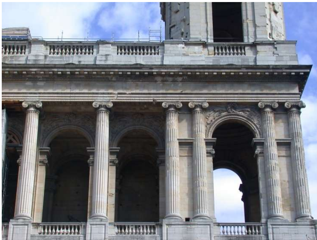
7-Détail de la façade de l'église Saint Sulpice à Paris, 1732-1745, de Servandoni, (cl. de l'auteur).
