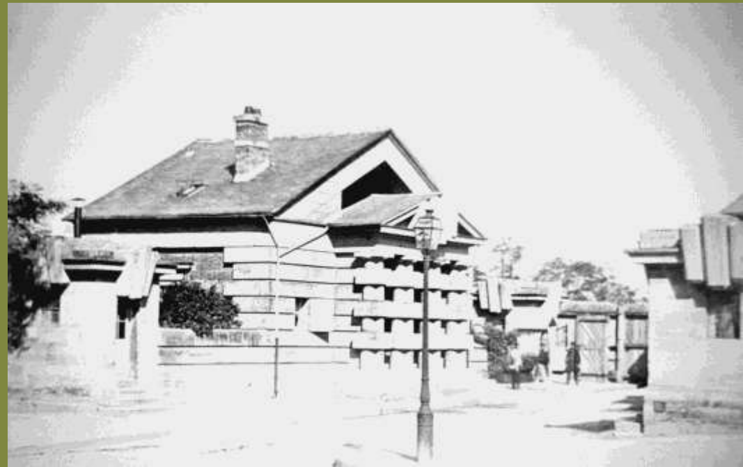
Ledoux, Pavillon des Fourneaux (détruit)
